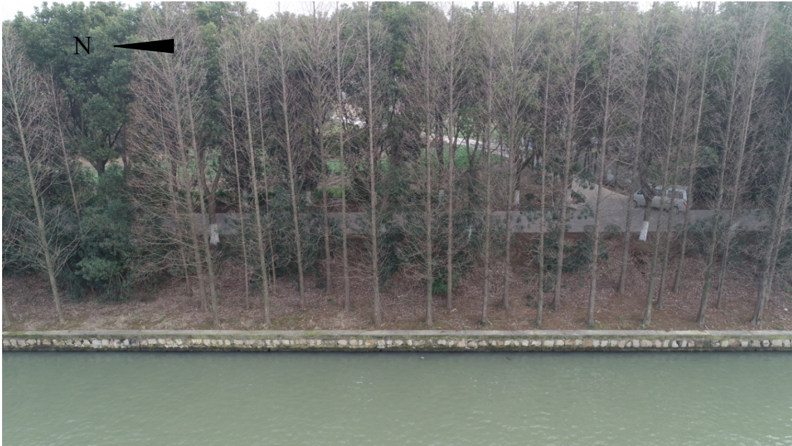
图 2-15 项目段东岸挡墙及堤防现状
