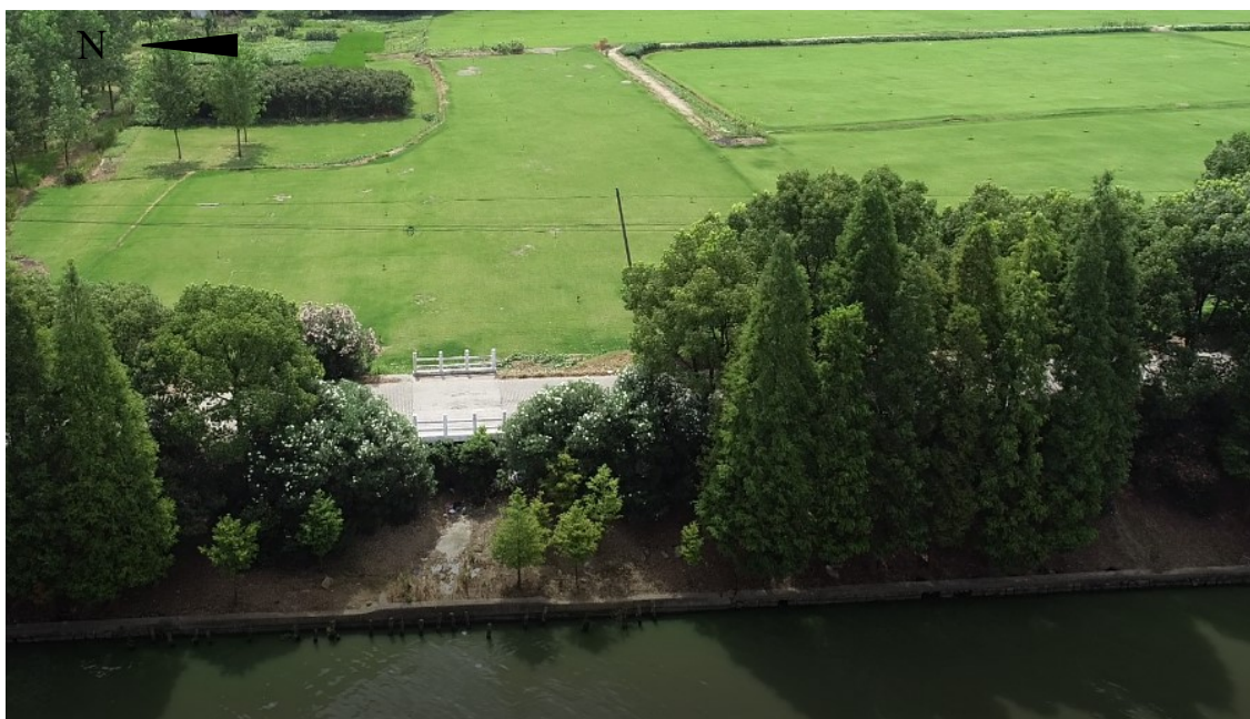
图 2-13 项目段东岸堤顶道路
