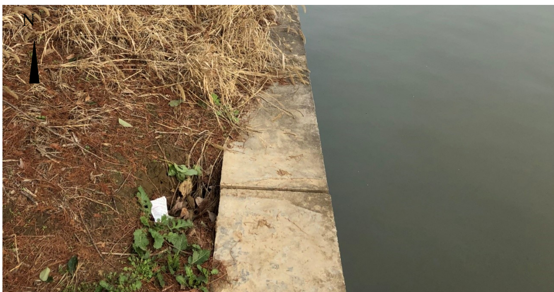
图 2-12 项目段西岸挡墙现状
