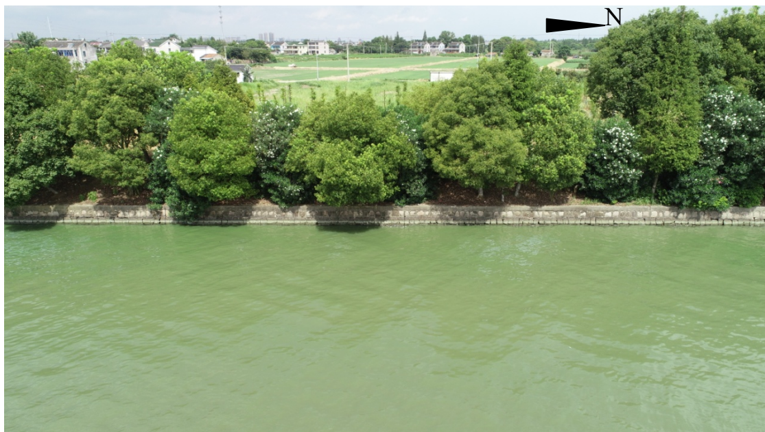
图 2-15 项目段西岸挡墙现状
