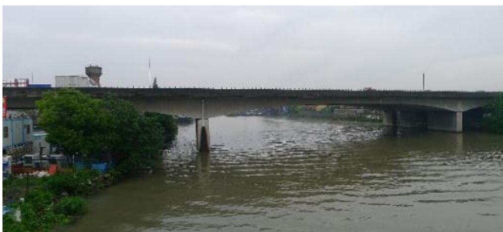
图 4.2-1 G1501 高速公路主桥立面实景(老桥)
