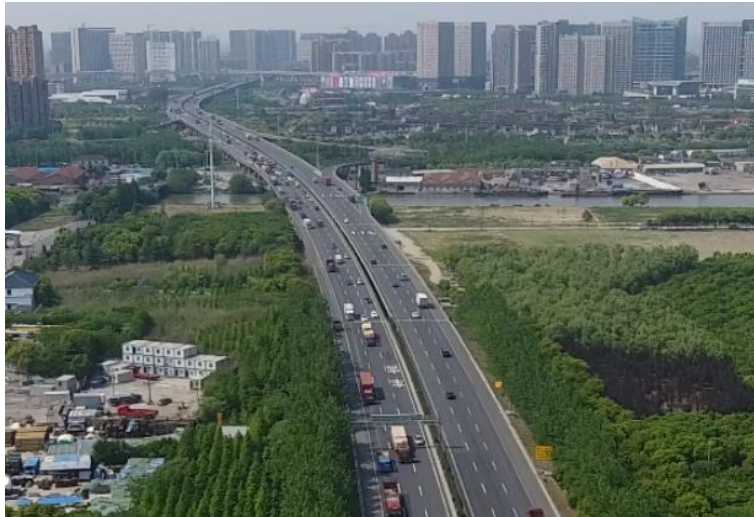
图 2.1-1 G1501 高速公路现状断面实景
