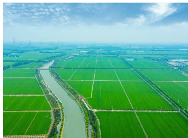
上海市松江区小汤山镇 现代农业示范区下流域
