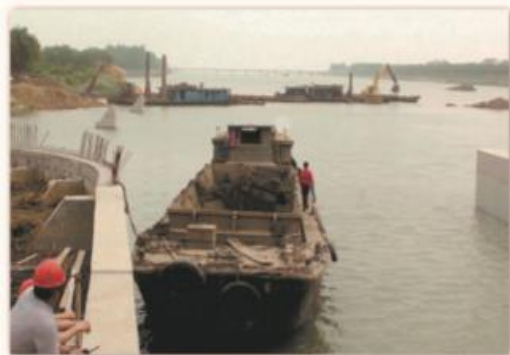
太浦闸通水围堰拆除
