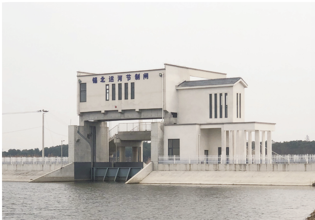
望虞河西岸控制工程锡北运河节制闸
