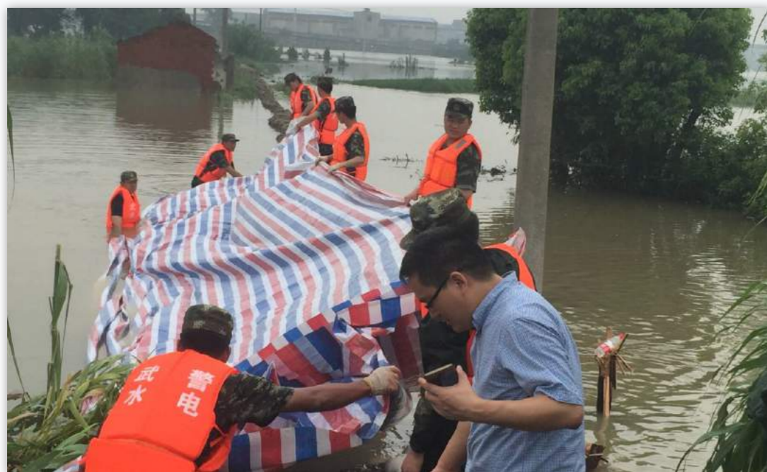
7月4日，武警水电二总队官兵在江苏省常州市武进区湟里镇抢险救灾
