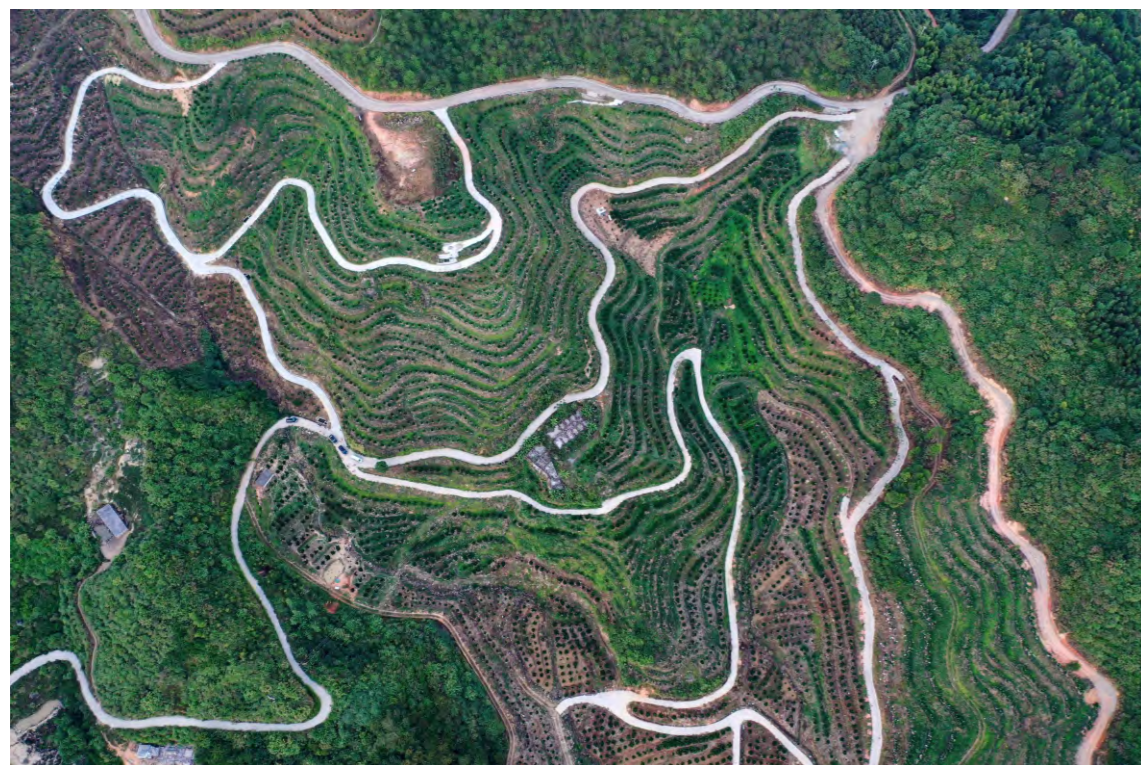
图2.2-1 福建省永春县坡耕地综合治理工程
