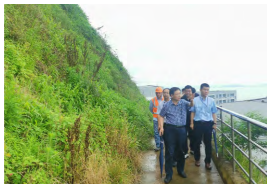
图 2.1-2 三门核电一期工程现场核查
