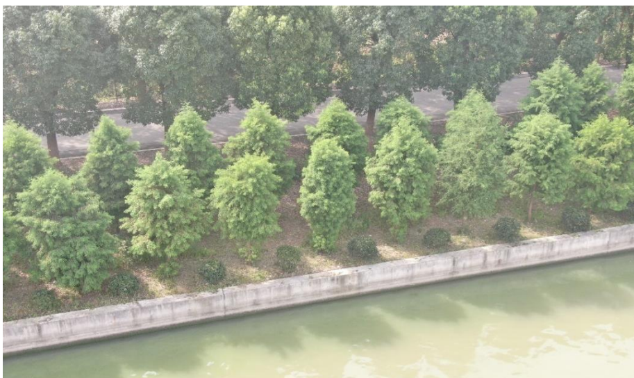
图 2.3-1 望虞河东岸挡墙
