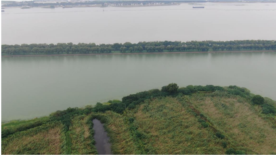
图 2.2-4 隧道穿越处太浦河
