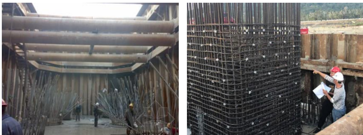
图 2.1-7 桥墩基坑围护施工案例
