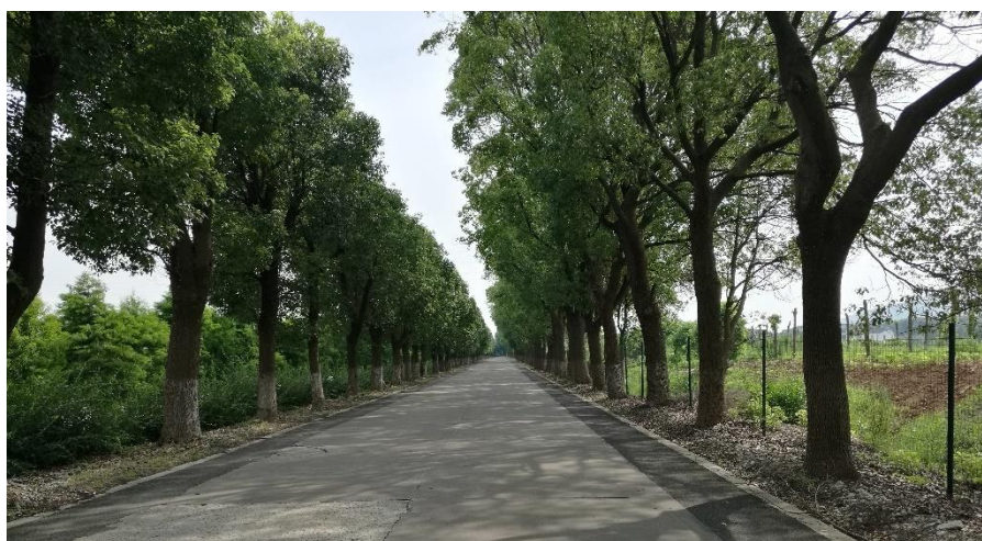
图 2.3-2 望虞河东岸堤防和防汛道路
