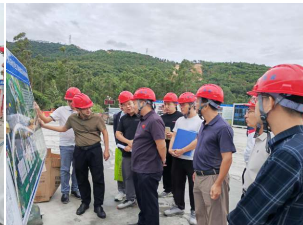
福建省国道G324线南安水头新营至厦门界段公路工程
