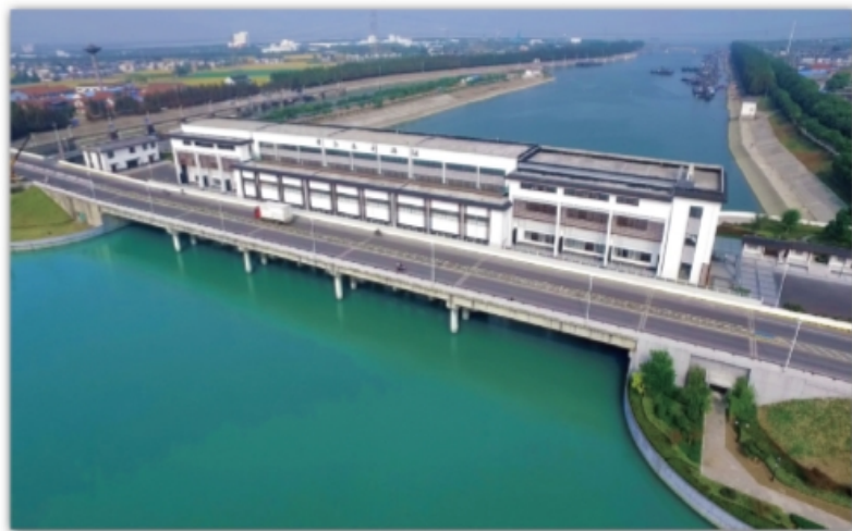
望虞河常熟水利枢纽工程
