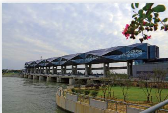
太浦闸除险加固工程
